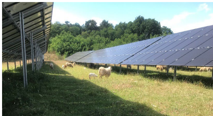
Abbildung 6: Extensive Schafbeweidung im Solarpark
