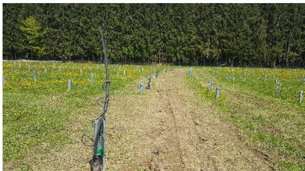
Abbildung 2: Verfüllter Kabelgraben
