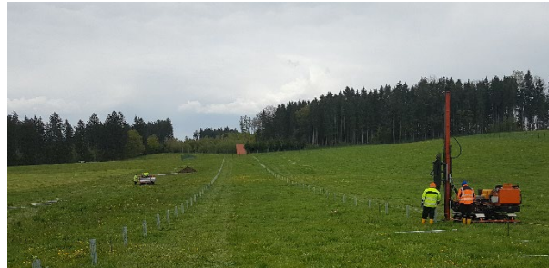
Abbildung 1: Hydraulikramme auf Ketten
